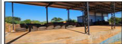
Foto 1 – Área de armazenamento de pneus, limpa e organizada.
